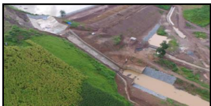
งานเขื่อนคอนกรีต
