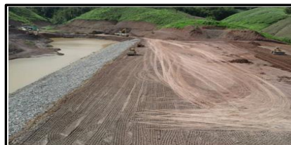
งานดินถมบดอัดแน่น
