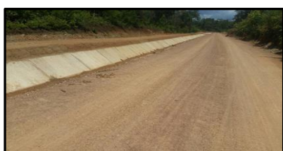
งานดินถมบดอัดแน่นด้วยเครื่องจักร
