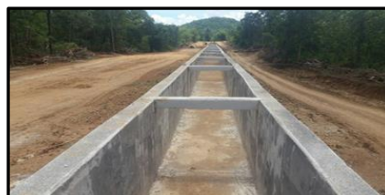
งานเทคอนกรีต
