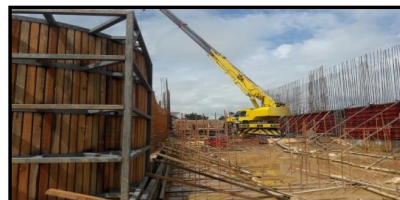
งานเขื่อนกรตเสริมเหล็ก
