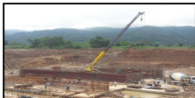
งานเขื่อนกรตเสริมเหล็ก
